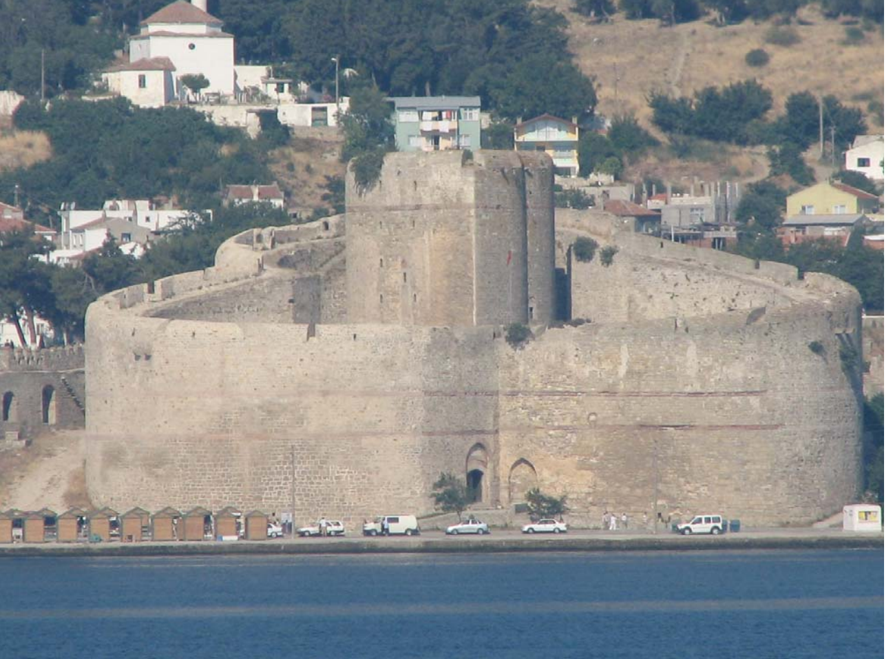
[F.4] Fotoğrafta, günümüzde önündeki hisarpeçe yıkılmış olduğundan giriş kapısı kolayca algılanabilen Kilitbahir iç kalesi görülmektedir.
