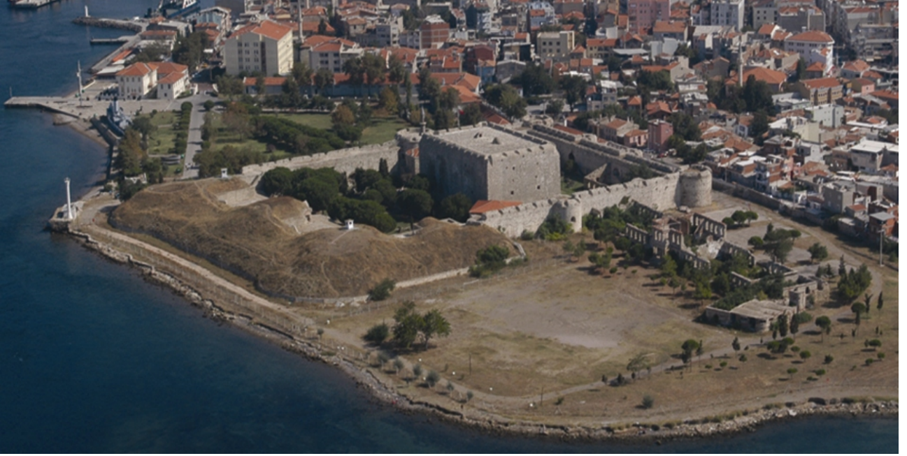
[F.4] Çimenlik Kalesi günümüzde Deniz Kuvvetlerine bağlı bir deniz müzesi olarak hizmet vermektedir. Bu yapının var olan bölümleri restore edilmiştir ve özellikle şansız dış hat kalelerine oranla çok iyi durumda sayılabilir. Ancak asıl bataryalarının yer aldığı deniz cephesi duvarları fotoğrafta da görülebileceği gibi toprak tabyaların yapılabilmesi için tahrip edilmiştir.
