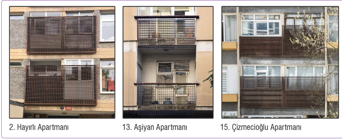
Şekil 15. Ahşap ızgara balkon korkulukları (fotoğraflar: Yapı 2 ve 13: Gönül, 2018; Yapı 15: Kurtuluş, 2016).
