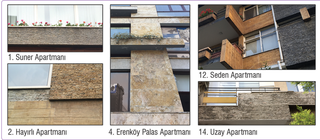
Şekil 24. Yapılarda traverten kullanımı (fotoğraflar: Gönül, 2018).
