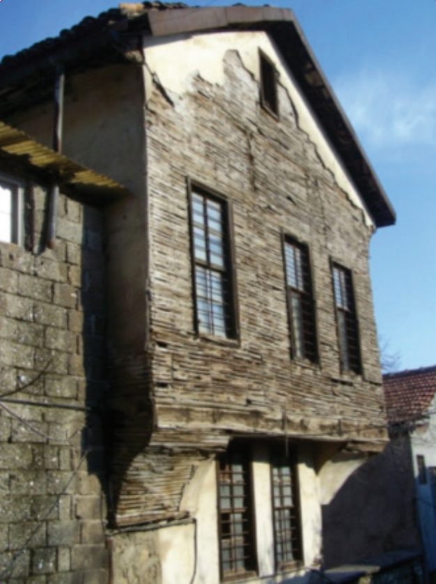
Şekil 14. Aahşap karkas üzeri bađdadi çıta tekniđi.
