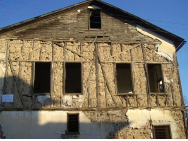
Şekil 13. Aahşap karkas arasına kerpiç dolgu tekniđi.
