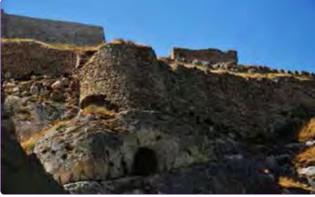
Şekil 11. Kuzey Burcu'nun üst kotundaki burçta duvar örgüsü kaybı.
