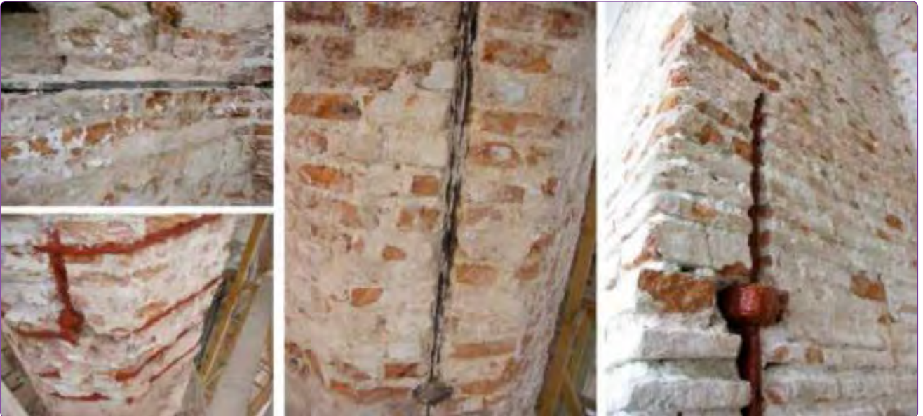
Şekil 14. Tuğla örgüde demir berkitme örnekleri (Kübra İnşaat, Salar).
