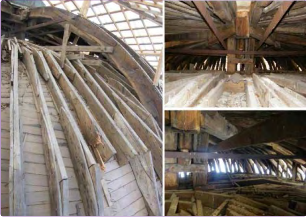
Şekil 20. Ahşap Kubbeden detaylar (Kübra İnşaat, Salar).
