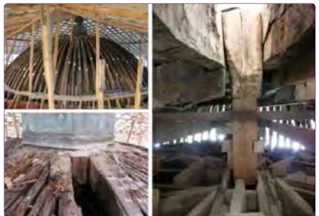
Şekil 19. Ahşap Kubbeden detaylar (Kübra İnşaat, Salar).
