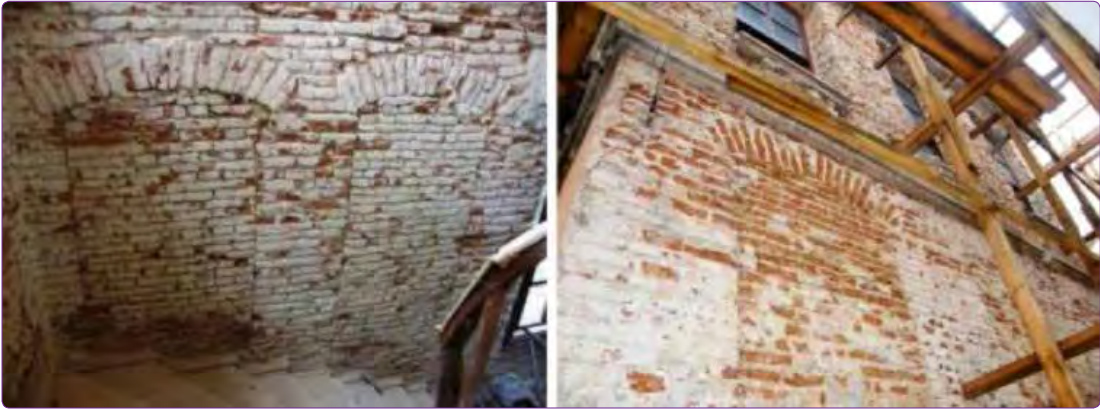
Şekil 12. Restorasyon sırasındaki raspa çalışmalarında ortaya çıkan pencere izleri (Kübra İnşaat, Salar).
