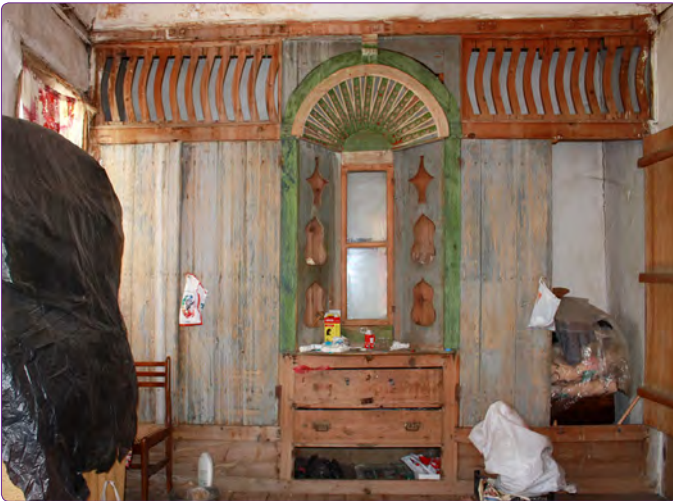
Şekil 40. Yüklük ve Şerbetlik örneği (Keskin, 91 ada 5 parsel). 57
