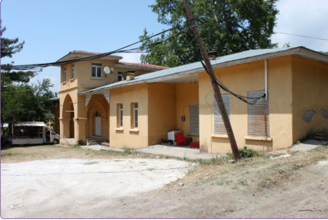
Şekil 8. Yarpuz Hükümet Konağı Ön Cephe (Kaynak: Nur Umar arşivi).
