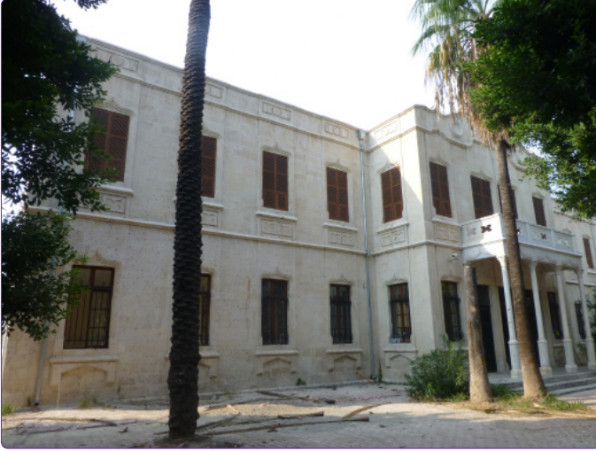
Şekil 10. Mersin Hükümet Konağı, 2014 (Kaynak: Nur Umar arşivi).
