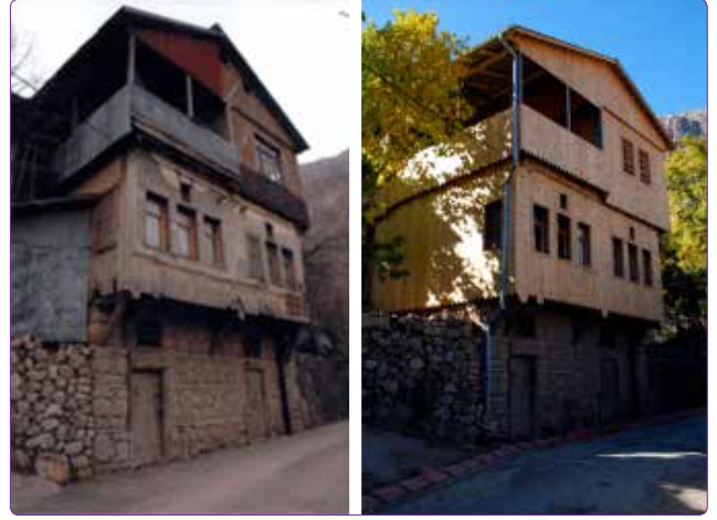
Şekil 12. Restorasyonu yapılan evin ön cephe eski ve yeni hali.””
