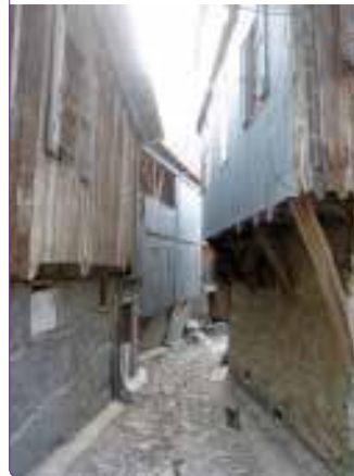
Şekil 10. Damların ve cephelerin sac malzeme ile kapatılması.
