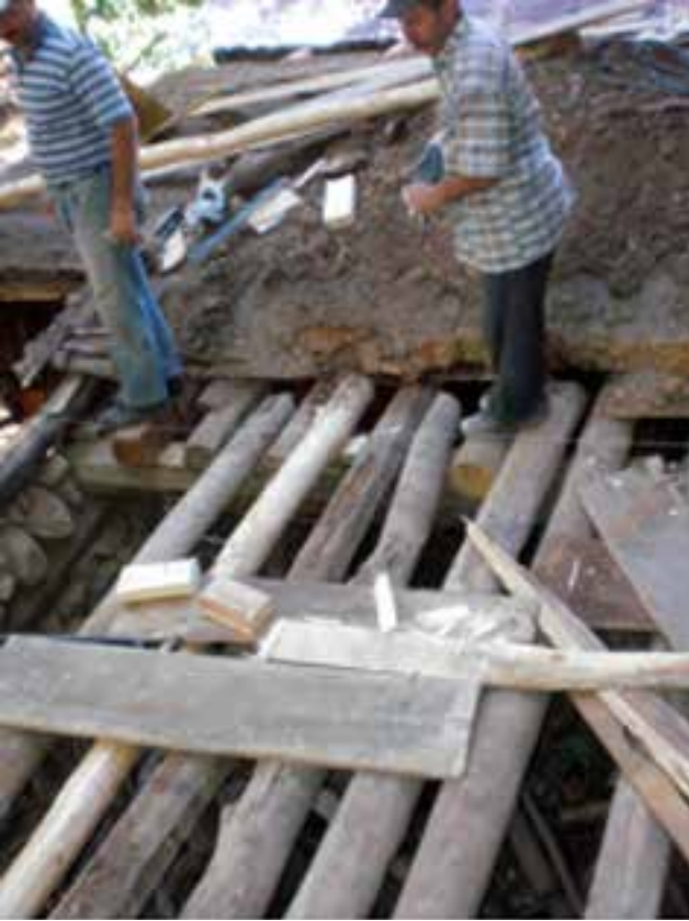
Şekil 13. Ahşap tavan kirişlerinin onarım aşaması.****
