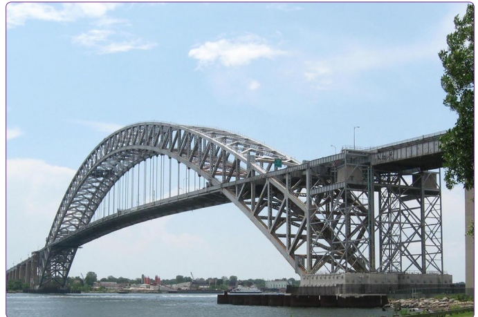
Şekil 1. Bayonne Köprüsü (Henderson, 2008).
