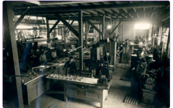
Şekil 23. Nuri Demirağ Beşiktaş Uçak Fabrikası, imalat atölyesinden genel bir görünüm. 55
