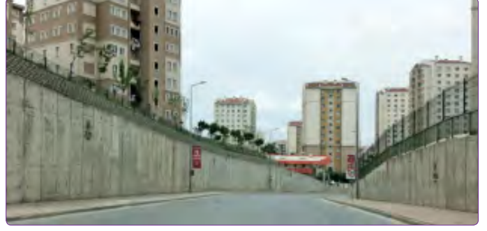
Şekil 3. Bölgede sıklıkla karşılaşılan yüksek istinat duvarlı yerleşimler.
