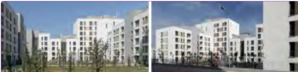
Şekil 13. Blok girişlerinin yer aldığı iç bahçeler.
