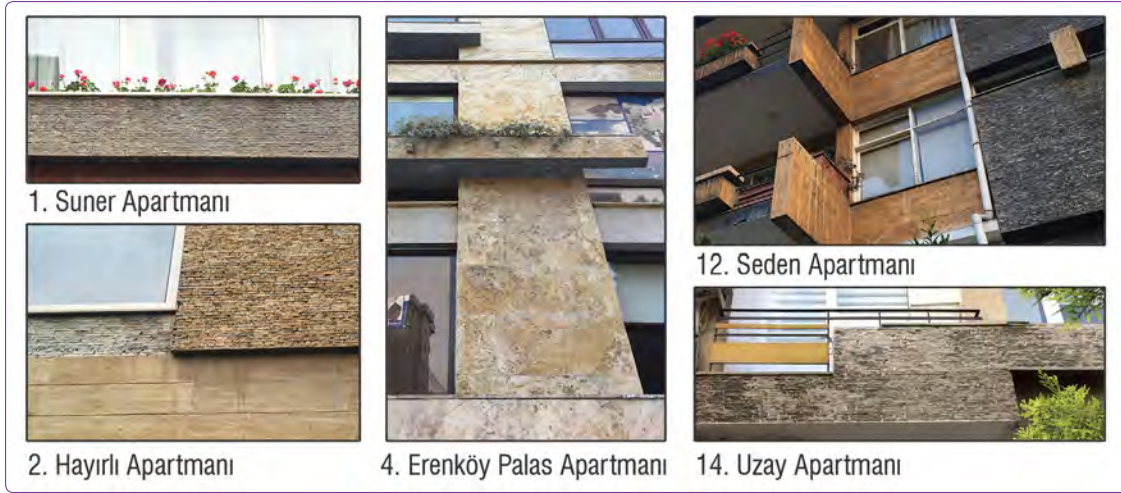
Şekil 24. Yapılarda traverten kullanımı (fotoğraflar: Gönül, 2018).
