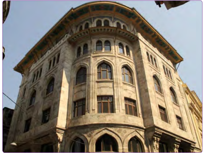
Şekil 9. Sokak cephelerinin detay görünüşü.
