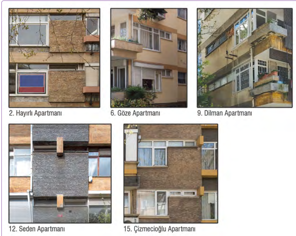
Şekil 4. Yüksek kotta kalan yatay pencerelerin diğer pencereler ile birleşimi (fotoğraflar: Kurtuluş, 2016).
