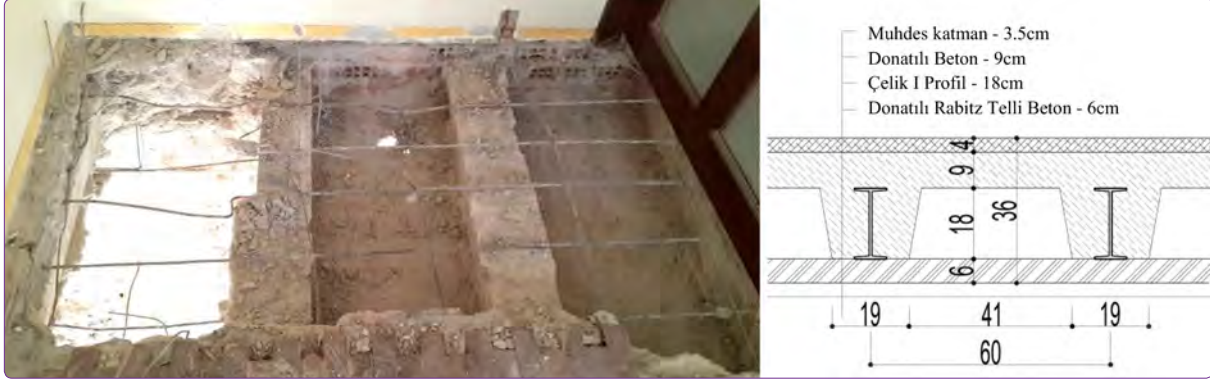
Şekil 19. Döşemedeki çelik profil, alt-üst donatılar ve kesit.
