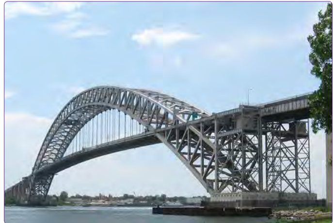
Şekil 1. Bayonne Köprüsü (Henderson, 2008).
