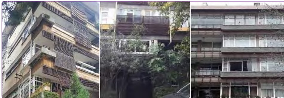
Şekil 5. Sırasıyla Dilman Apartmanı, Çizmecioğlu Apartmanı ve Suner Apartmanı'nda gridal eleman kullanımı (Efsun Ekenyazıcı Güney ve Hande Tulum Okur arşivi, 2020).
