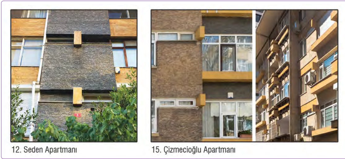
Şekil 20. Yalancı kirişler (fotoğraflar: Yapı 12: Gönül, 2018; Yapı 15: Kurtuluş, 2016).
