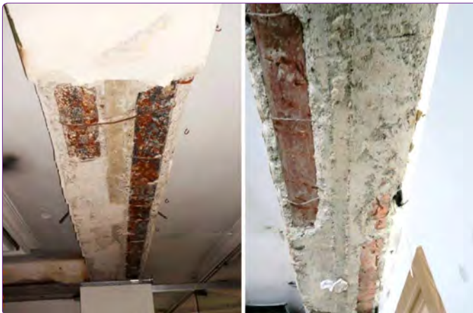
Şekil 14. Ana kirişlerdeki çelik profiller ve onları saran ince donatılar.
