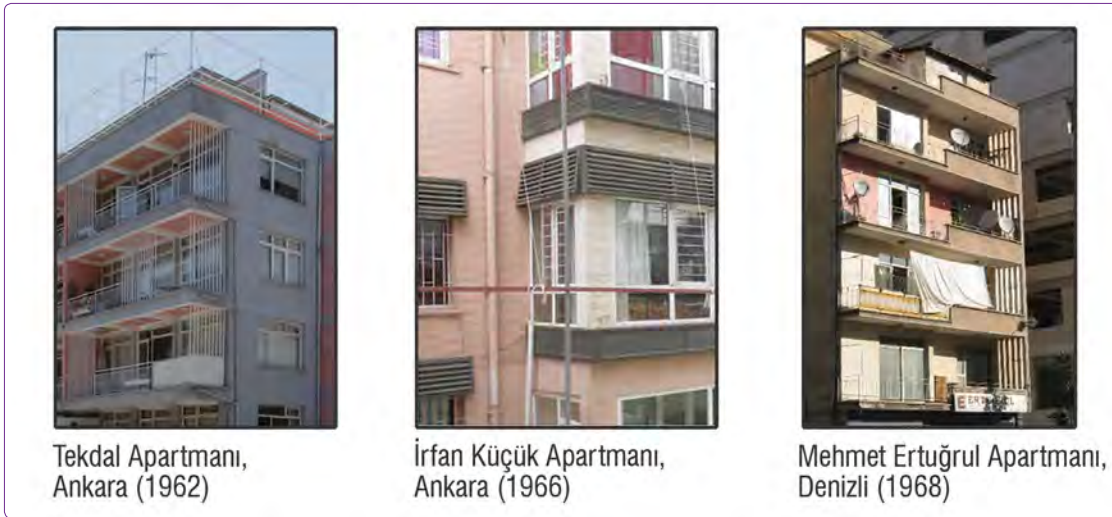
Şekil 14. Konut yapılarındaki güneş kırıcı öğeler: Ankara (Bayraktar, Batuman ve Ayhan, 2014, s. 186 ve 222) ve Denizli (Avsan, 2015, s. 102) kentlerinden örnekler.
