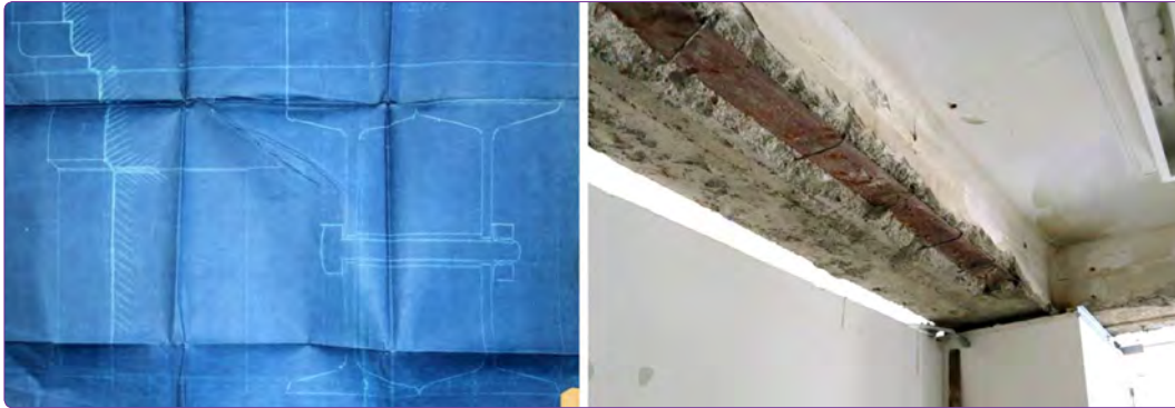
Şekil 13. Özgün paftada (Vakıflar Genel Müdürlüğü arşivi) ve yerindeki ana kirişte (asma kat) çelik profiller ve bağlantılar.
