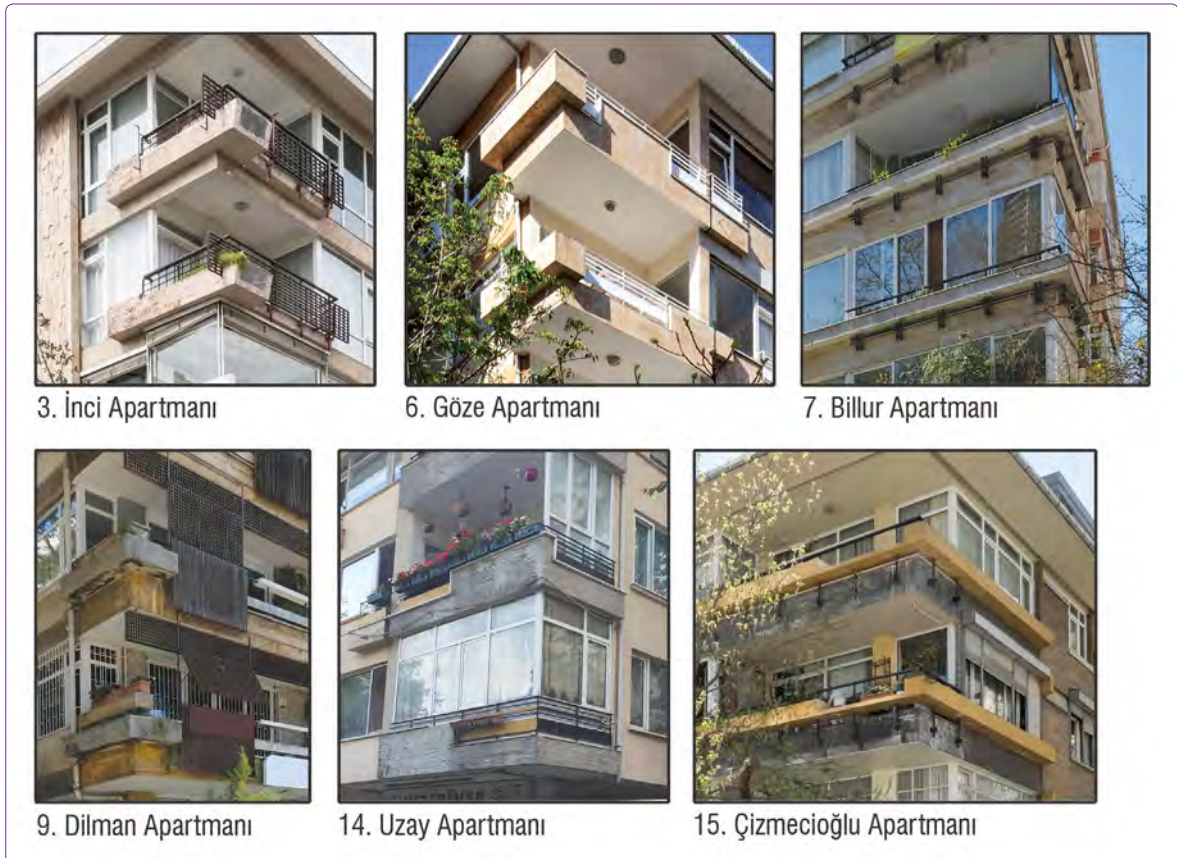
Şekil 10. Çiçeklik detayları (fotoğraflar: Yapı 3, 6, 7, 9, 15: Kurtuluş, 2016; Yapı 14: Gönül, 2018).
