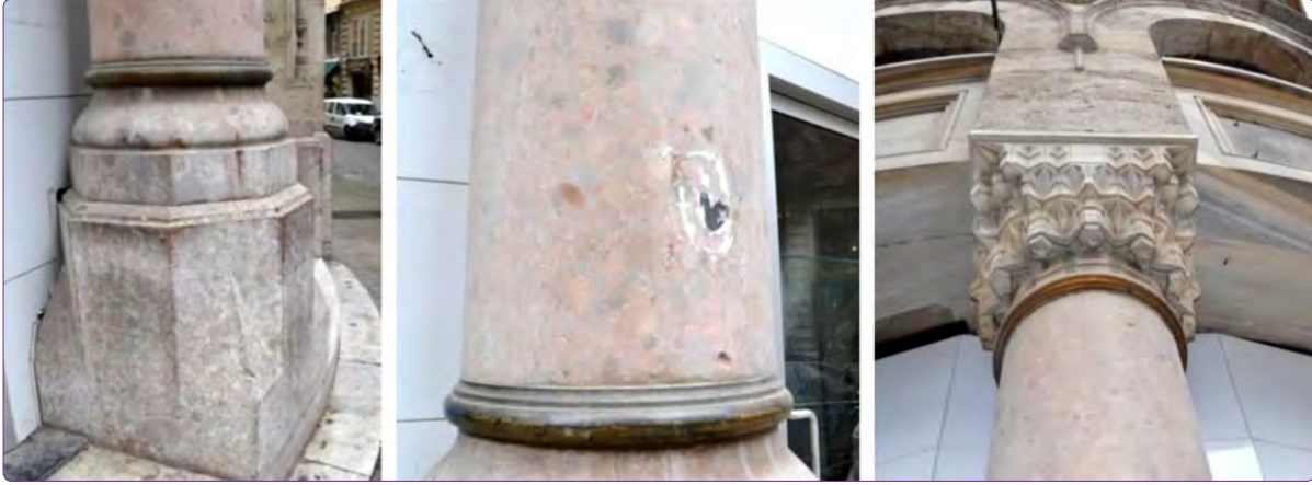
Şekil 10. Binanın dükkân girişindeki doğal taştan yapılmış sütun, kaide ve başlığı.
