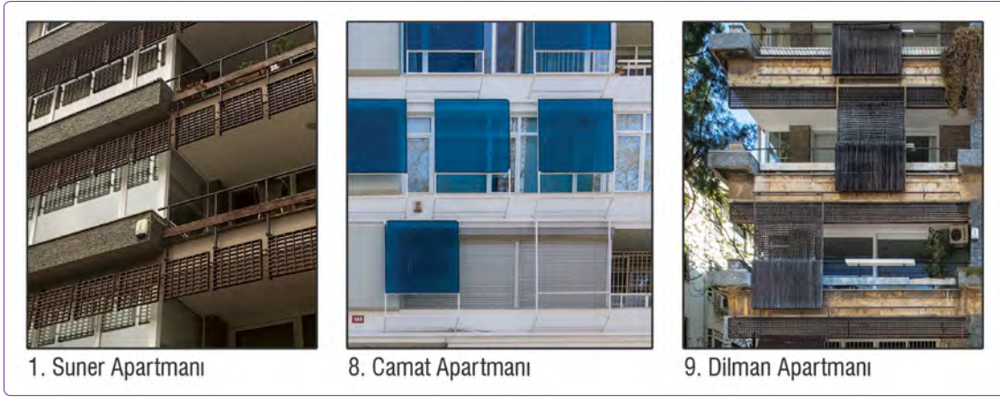
Şekil 13. Güneş kırıcılar (fotoğraflar: Yapı 1: Gönül, 2018; Yapı 8 ve 9: Kurtuluş, 2016).
