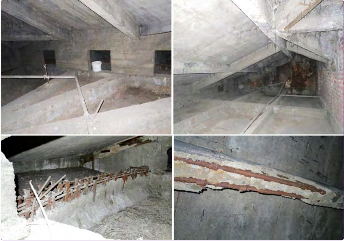
Şekil 23. Çatıdaki kirişlerin Hennebique tekniğindeki donatıları.
