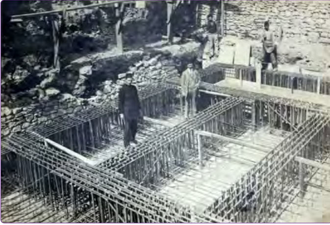
Şekil 20. Mimar Kemaleddin tasarımı 4. Vakıf Han'ın betonarme temel inşaatından görüntü (Vakıflar Genel Müdürlüğü arşivi).
