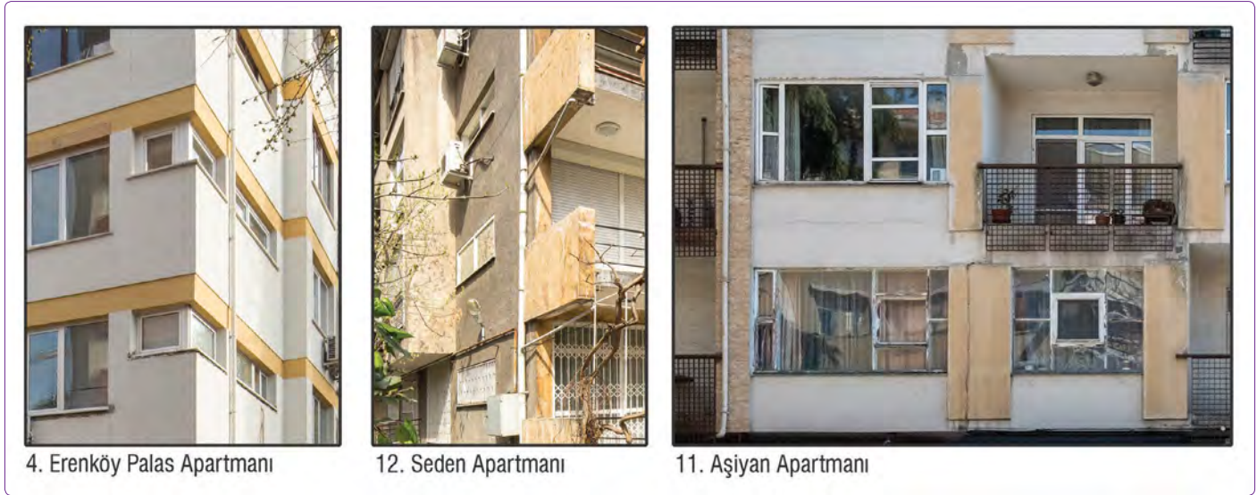
Şekil 5. Bant pencereler ve geometrik kompozisyon oluşturacak şekilde kurgulanmış doğramalar (fotoğraflar: Kurtuluş, 2016).
