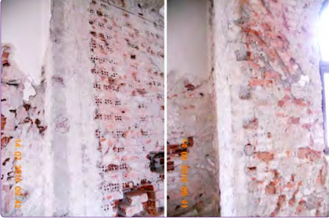
Şekil 16. Boşluklu ve dolu tuğla örgü ile bütünlüğe getirilen betonarme kolonlar.
