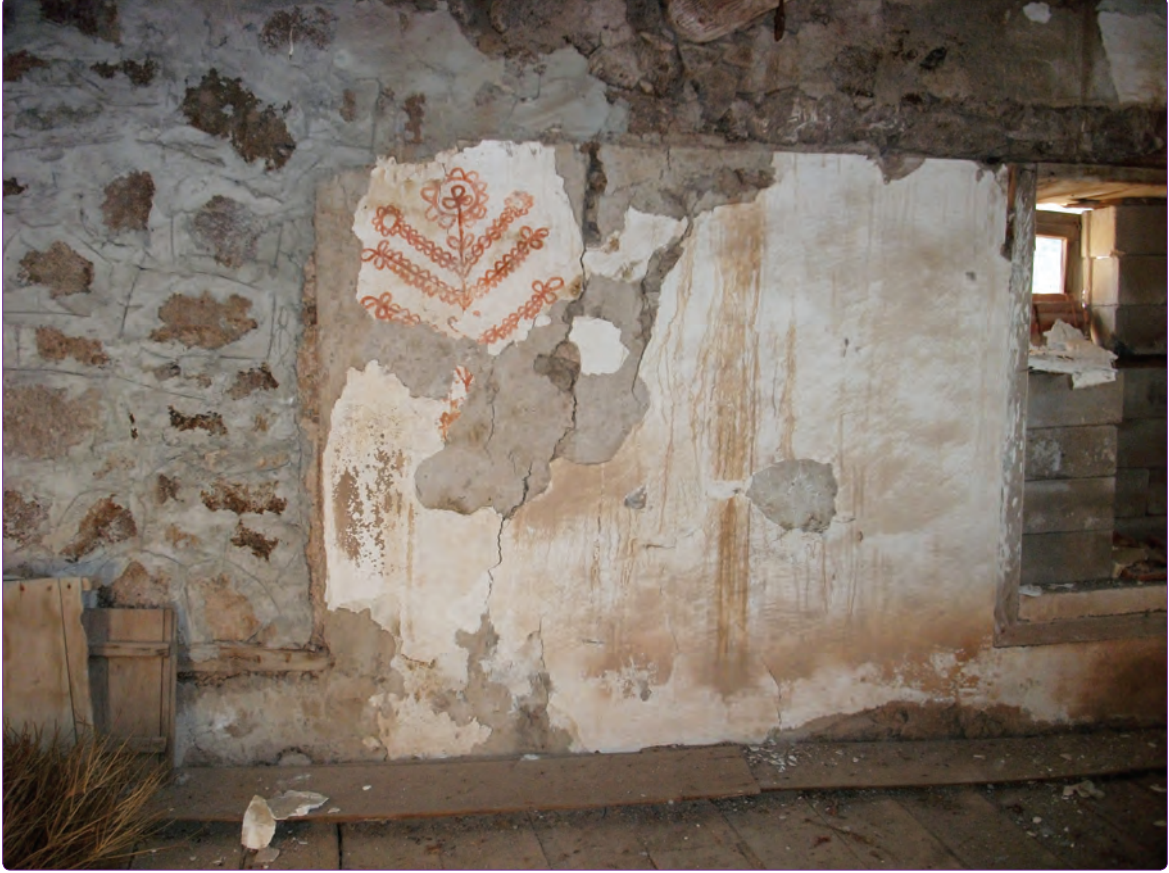
Şekil 25. İç mekan duvar boyası süslemesi.
