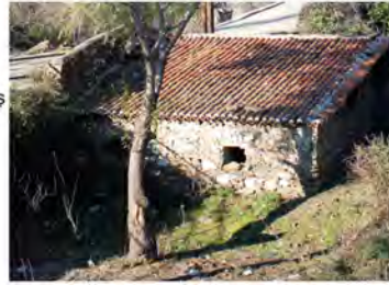
Foto. 29: Çamaşırhane güney cephesi
