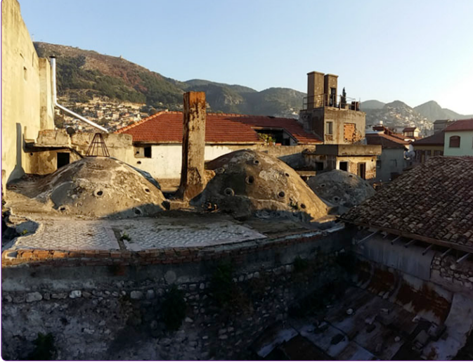
Şekil 22. Yapılarla çevrili olan Beyseri Hamamı'nın kuzey-batıdan görünümü. Üst örtüye eklenmiş muhdes kütleler, daha sonra kalkmış olan muhdes bir kütlelerin zemin döşemesi ve ılıklik ile soğukluk arasındaki baca görülmektedir. (Fotoğraf: Yazar, 2017).
