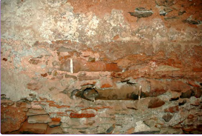
Şekil 8. Sıcaklık bölümünde sıcak ve soğuk su hattı olarak döşenen künkler (Fotoğraf: Yazar, 2008- İzmir, Tire-Tahtakale Hamamı).
