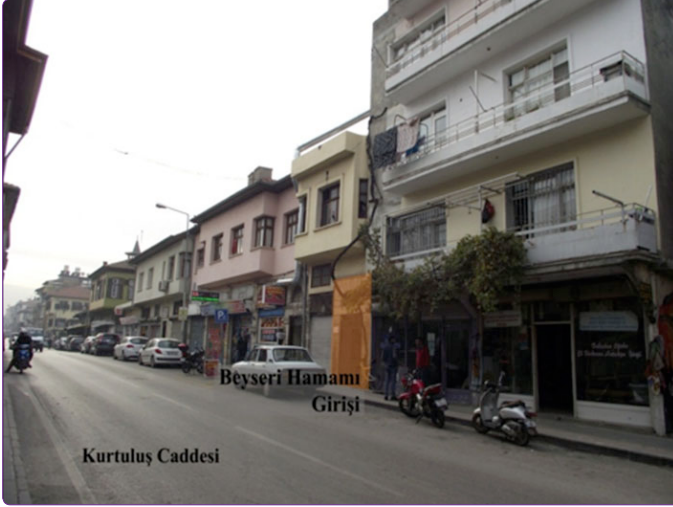
Şekil 18. Beyseri Hamamı'nın Kurtuluş Caddesi üzerinde bulunan giriş kapısı ve yakın çevresi (Fotoğraf: Yazar, 2017).
