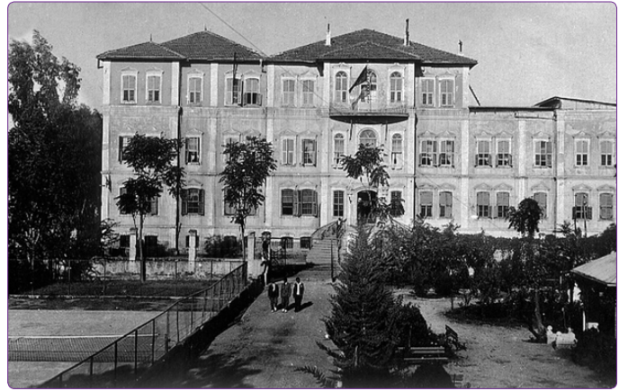
Şekil 4. Adana Hükümet Konağı II. Dönem (Kaynak: Adana Hükümet Konağı Dosyası, Adana Kültür Varlıklarını Koruma Kurulu Arşivi).
