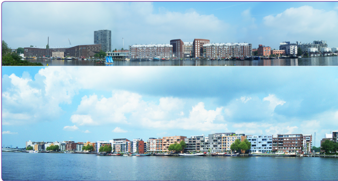
Şekil 6. 100 konut/ha yoğunluğu ve %30,7 zemin payına sahip, KNSM yerleşimi ve 96 konut/ha yoğunluğu ve %26 zemin payına sahip Java yerleşimi, Amsterdam (Burak Mangut fotoğraf arşivi).
