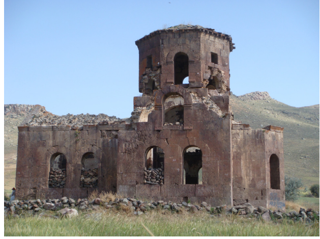
Resim 13. Kızıl Kilise, güney cephesi
