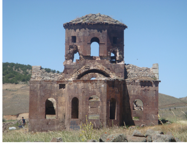
Resim 14. Kızıl Kilise, doğu cephesi
