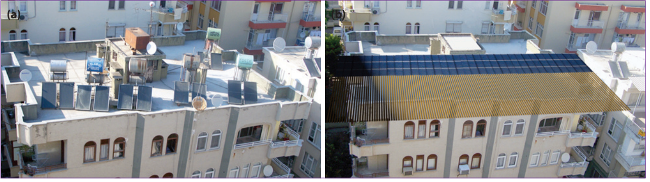
Şekil 13. (a, b) Varolan sistemlerin merkezi sistem ve pergola ile bütünleşik olarak yenilenmesi.
