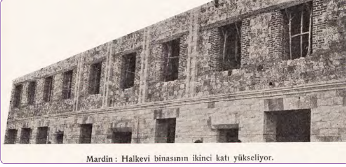
Şekil 17. Halkevi Binası inşaatı. 46
