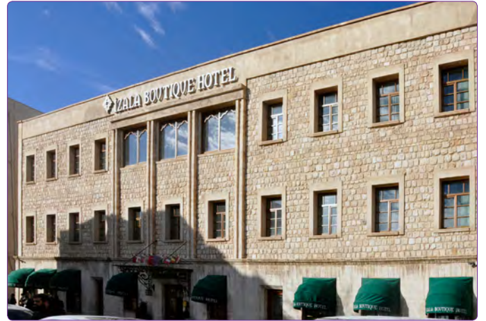
Şekil 38. Halkevi binası restorasyon sonrası cephesi, 2011.
