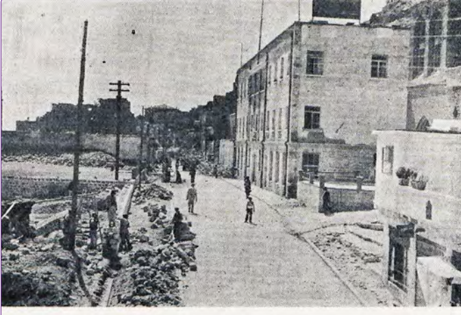
Halk bahçesinde toprak tesviyesi
