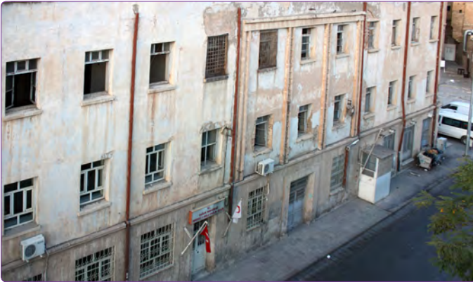
Şekil 37. Halkevi binası restorasyon öncesi cephesi, 2009.
