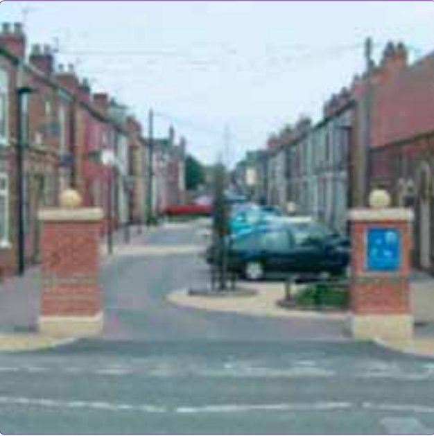
Şekil 8. “Home Zone” olarak düzenlenmiş sokağın giriş yeri (DFT, 2005).
