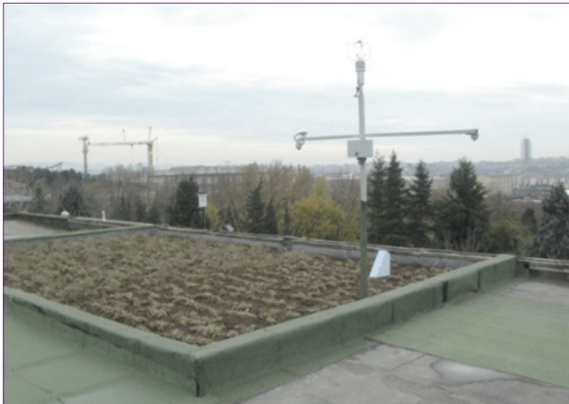
Şekil 1. Bitkilendirilmiş test çatı sistemi ile mevcut test çatı sisteminin görünüşü.
