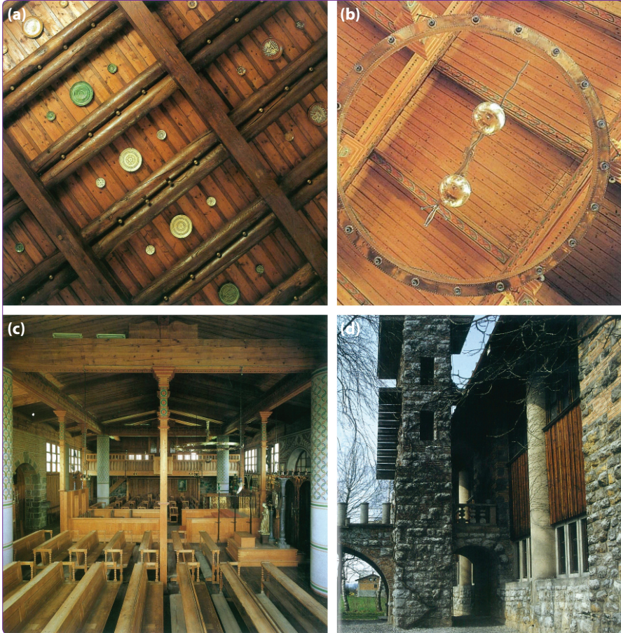
Şekil 10. (a) 25. Bogjina’da kilisesi, ana ibadet salonu, ahşap tavan (1930). (b) Aziz Mikail Kilisesi, ana ibadet salonu, avize (1940). (c) Aziz Mikail Kilisesi, ana ibadet salonu (1937-38). (d) Aziz Mikail Kilisesi ön cephesi (1937-38).
