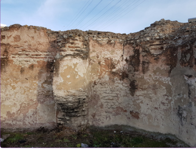
Şekil 6. Duvar örgüsü, sıva ve pahlı yüzeyler (Altuğ, 2020).
