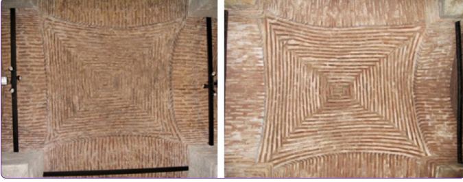
Şekil 16. İstanbul sarnıçlarından çapraz tonoz örnekleri [Sultan Sarnıcı (Bonos Sarnıcı?) ve Yerebatan (Bazilika) Sarnıcı] (Altuğ, 2013).
