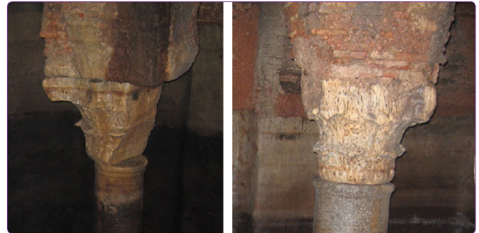
Şekil 18. Sarnıçlarda sütun ve devşirme başlık örnekleri (Altuğ, 2013).
