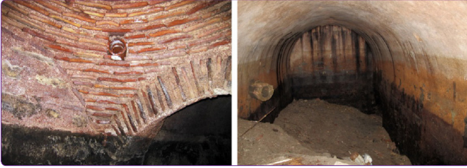
Şekil 20. Sarnıç besleme elemanı örnekleri (Altuğ, 2013).
