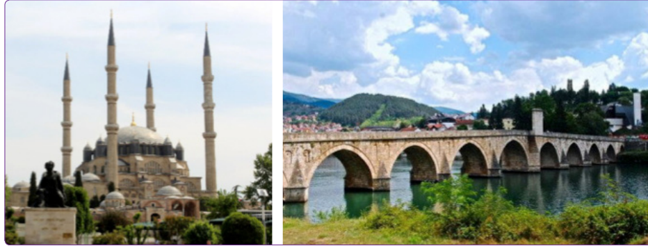
Şekil 10. Mimar Sinan'ın Yapıları (Sınır Aşırı Seri Miras: Mimarlar Örneği) Selimiye Camisi (Türkiye, 2011); 13 Sokullu Mehmet Paşa Köprüsü (Vişegrad, Bosna Hersek, 2007). 14
