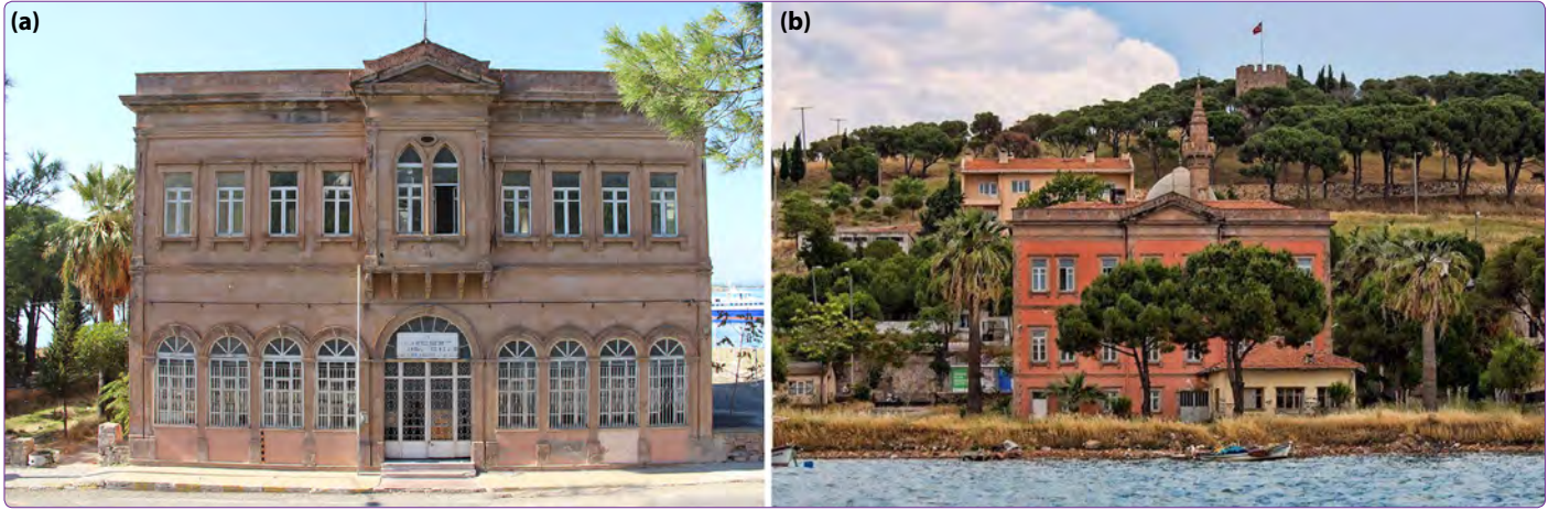
Şekil 4. (a) Georgala Han'ın Atatürk Bulvarı'na bakan giriş cephesi; (b) Han'ın deniz cephesi.
