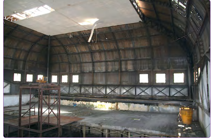
Şekil 15. Galata Rüsumat Binası orta mekan (Banu Çelebioğlu).
