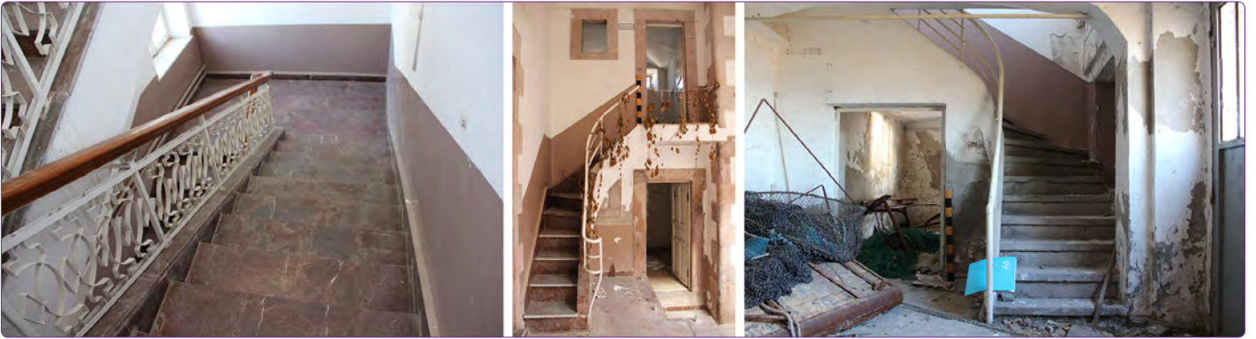
Şekil 9. Sırasıyla sonradan eklenen betonarme üst kat merdiveni; sonradan eklenmiş asma kat merdiveni; bodrum kata inen dökme merdiven.
