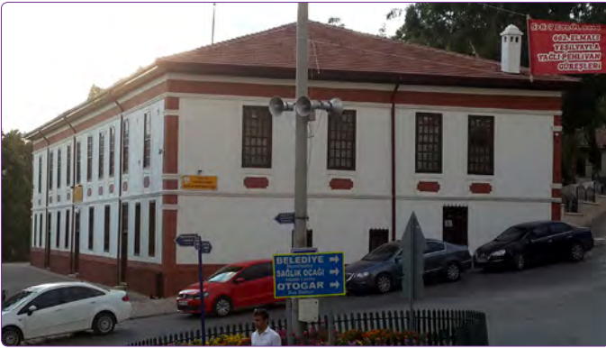
Şekil 10. Mustafa Kocakaya İlkokulu, restorasyon sonra güneydoğudan görünüm.
