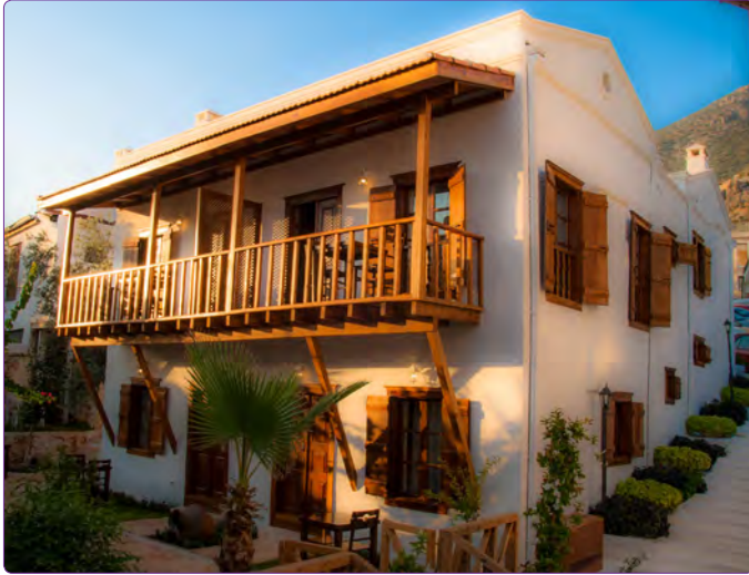
Şekil 26. Courtyard Otel (Hüseyin Ağa Evi)'nden güney cephesinde geniş çıkma, 2013 restorasyondan sonra.
