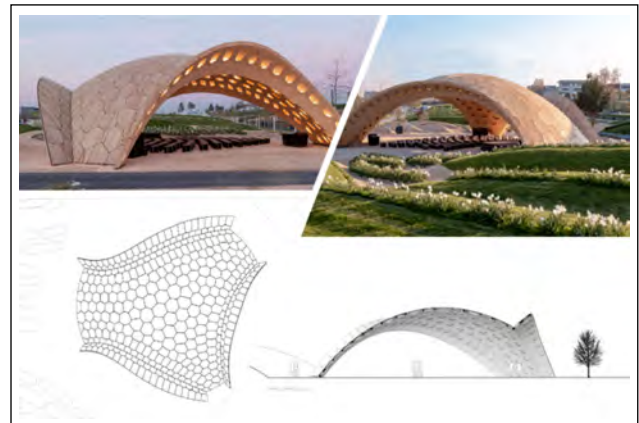
Şekil 6. Parametrik biçim grameri ile tasarlanmış örtü elemanı, Stuttgart Üniversitesi (German Design Council, 2019).
