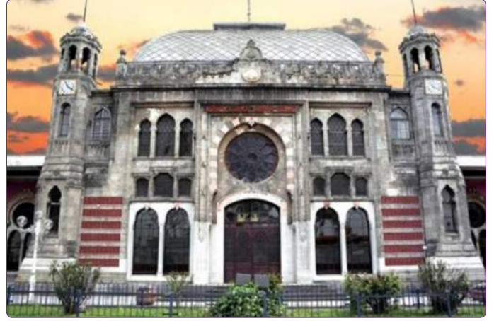
Şekil 21. Sirkeci Garı ön cephe. 58
