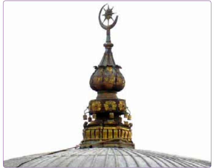
Şekil 5. İstanbul, Beyoğlu, Dolmabahçe Camisinin (M.1855) ay - yıldızlı tepelikli alem detayını gösterir fotoğraf (Kaynak: Vakıflar Genel Müdürlüğü Arşivi, 2016).
