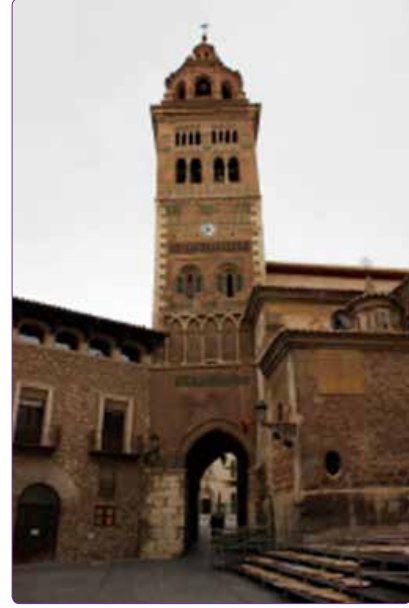
Şekil 1. Santa Maria Katedrali ve Çan Kulesi, Teruel, 1171-1587 (Catedral de Santa Maria y Torre) (Kaynak: Yazar tarafından çekilmiştir).
