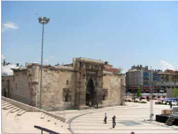
Şekil 5. Buruciye Medresesi ve çevresinde yapılan düzenlemeler.
