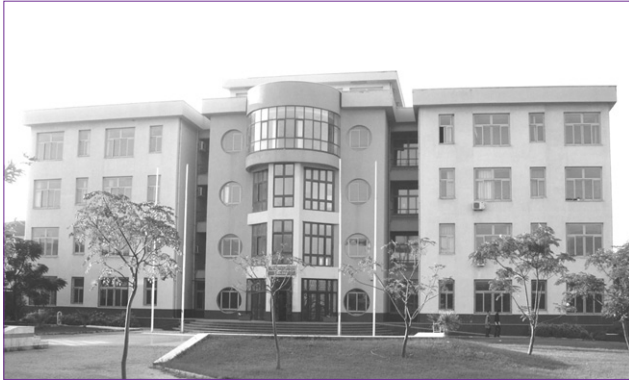
Şekil 2. Ege Üniversitesi İnşaat Mühendisliği Bölümü binası.
