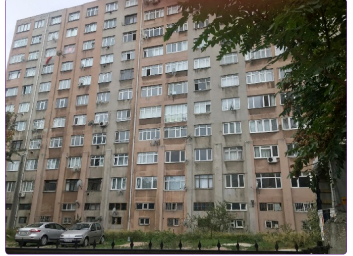
Şekil 3. Çok katlı, çok yoğun ve gözetimi zor binalar. Basinsitesi, Bahçelievler (2018, T. Koca).
