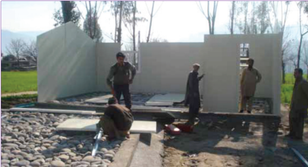
Şekil 4. Pakistan'daki metal sandviç panel geçici eğitim birimlerinin dış duvar bileşenlerinin montajı. 12
