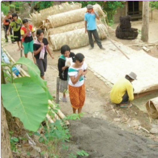
Şekil 5. Endonezya'da yerel işgücü ile geçici eğitim birimlerinin oluşturulmasında gerekli yapı bileşenlerinin taşınması ve şantiye alanında tesviye çalışmalarının yapılması. 16
