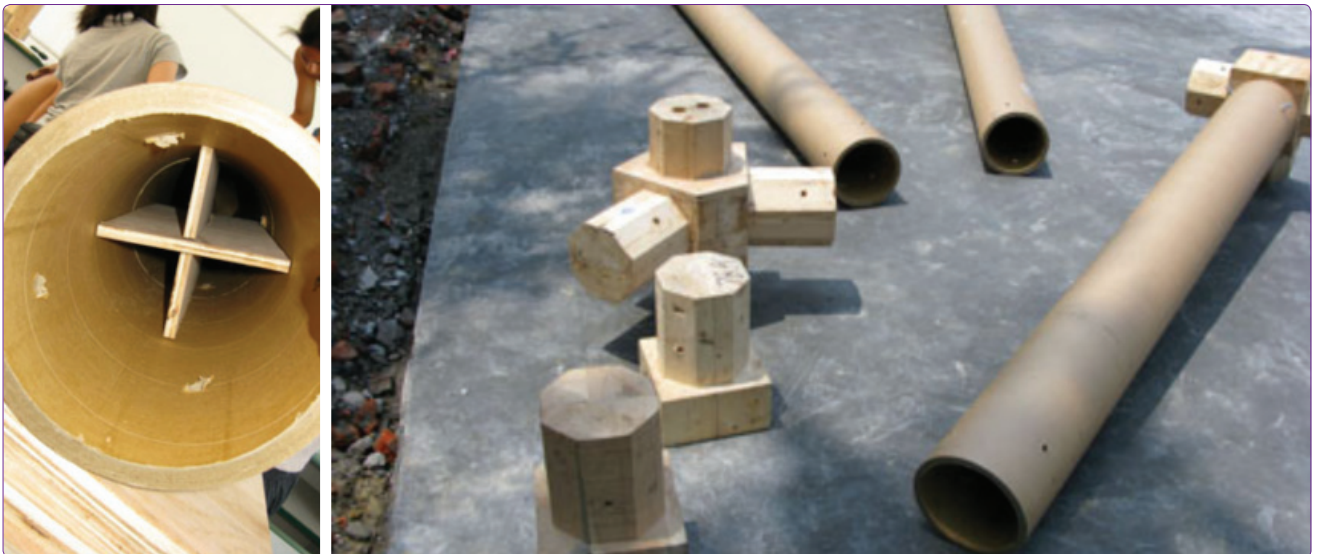
Şekil 3. Çin'de geçici eğitim birimlerine ait kağıt tüp kolon ve giriş elemanları ve bağlantı elemanları. 13
