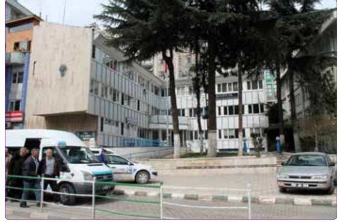
Şekil 24. Emniyet Müdürlüğü Binası'nın İnönü Caddesi'nden görünüşü (Güler, 2015).
