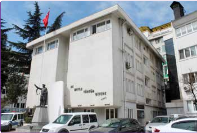
Şekil 23. Eski Hükümet Konağı'nın yerine inşa edilen Defterdarlık Binası (Güler, 2015).
