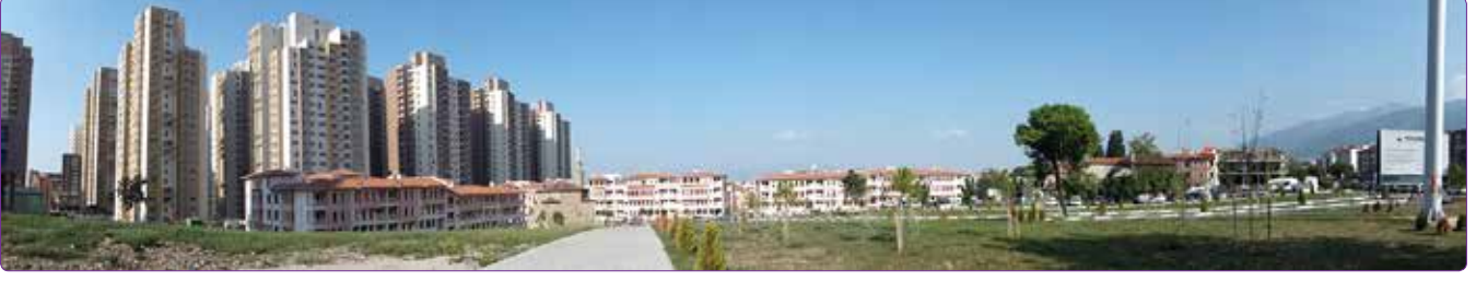
Şekil 6. Doğanbey kentsel dönüşüm uygulaması.
