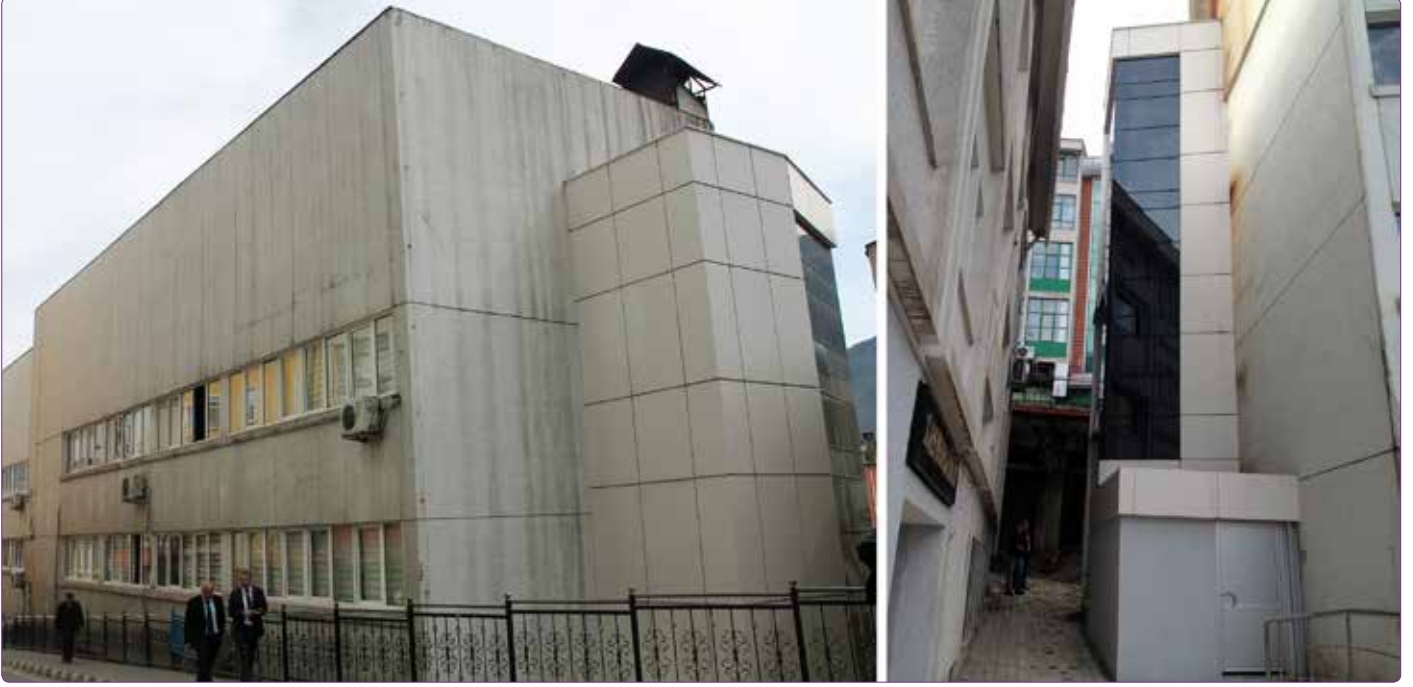
Şekil 31. Yapıya sonradan eklenen asansörlerden görünüşler (Güler, 2015).
