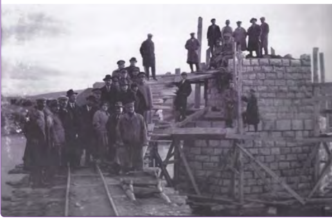
Şekil 28. Kayseri tren yolu yapımı, 1926 (Karakaya, 2006, s. 130).
