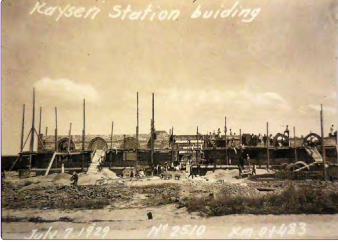
Şekil 5. Kayseri Tren İstasyonu inşaatı, 7 Temmuz 1929 (Halit Erkiletlioğlu Arşivi).
