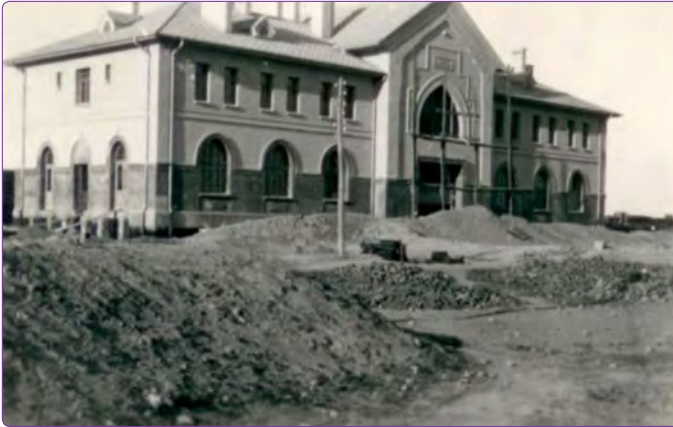
Şekil 13. Kayseri Tren İstasyonu binası önündeki meydanın yapımı (Şahin, 2013, s. 9).
