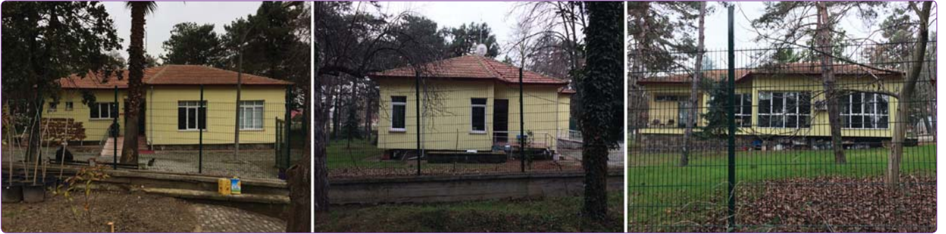
Şekil 5. A tipi konut batı (giriş), kuzey ve doğu (arka) cepheler (2021).
