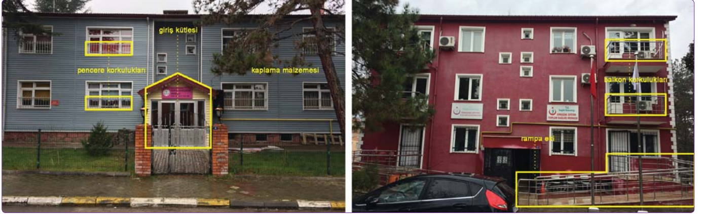
Şekil 25. Yapılardaki eklere ve malzeme değişimlerine örnekler.
