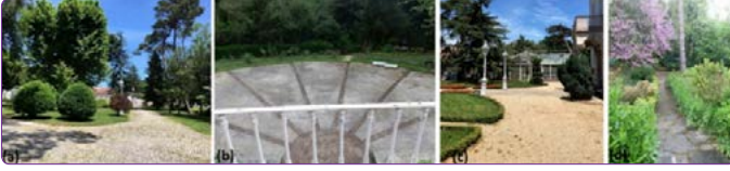
Şekil 11. Küp şeklinde granit taşları ile yapılmış yer döşemesi (a); İnce agregalar ve çimento kullanılarak yapılmış meydan tasarımı (b); Kum ve çakıl ile kaplı yol döşemesi (c); Kayrak taşı ile kaplı yol döşemesi (d).
