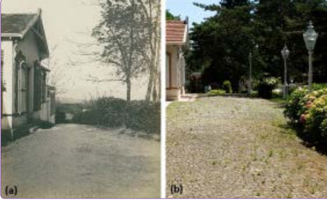
Şekil 18. 20. yüzyıla tarihlenen resimde Paşalar Dairesi'nin önünde yer döşemesi olarak sıkıştırılmış toprak kullanıldığı, günümüzde kullanılan ve 18b'de görülebilen aydınlatma öğelerinin o tarihte bulunmadığı anlaşılmaktadır. 33 Ayrıca 18a'da görülen eski fotoğraftan bu alana aydınlatma öğelerinin sonradan yerleştiği anlaşılmıştır.
