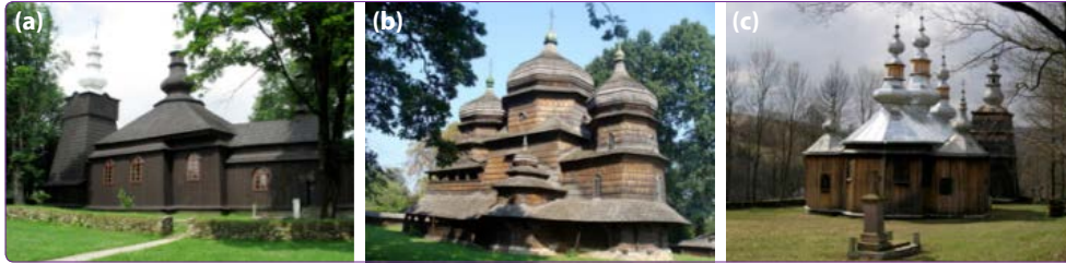
Şekil 4. Polonya ve Ukrayna Karpas Bölgesi'ndeki Ahşap Kiliseler (2013) (Yapı Malzemesi ve Yapım Teknikleri Örneği) 4
