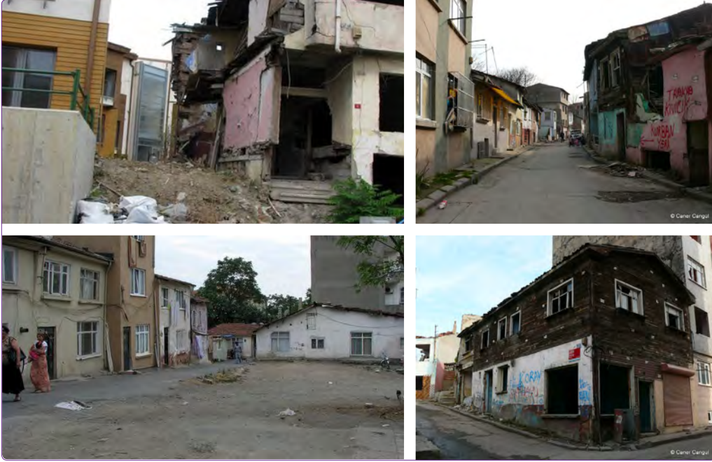
Şekil 2. Sulukule Bölgesinin Yıkımdan Önceki Hali 44 (Koca, 2013).
