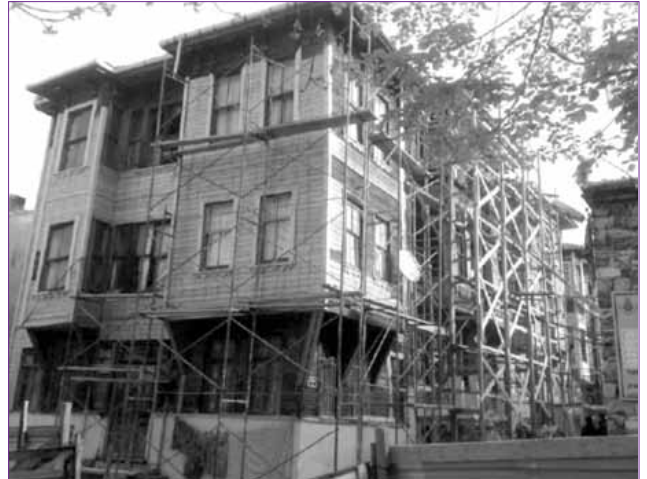
Şekil 3. Dış cephesi KUDEB tarafından yenilenen bir konut.
