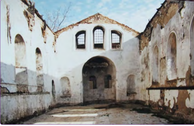
Şekil 10. Selimpaşa Kilise Camisi'nin 18 yıl kullanılmaması sonrası görünümü, doğu cephesi (2001) (KVKBKA).
