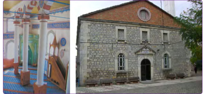
Şekil 16. Osmanlı Camisi'nin restorasyon öncesi iç mekan (solda) ve batı cephesi (sağda) görünümü (2010) (KVKBKA).
