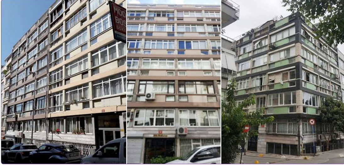
Şekil 6. Sırasıyla; Kent ve Moda Palas Apartmanı (bitişik), Moda Palas Apartmanı girişi, Özoğuz Apartmanı (Efsun Ekenyazıcı Güney ve Hande Tulum Okur arşivi, 2020).
