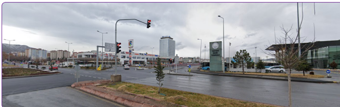
Şekil 19. Şehirler arası otobüs terminali, BYZ Garage AVM, Meysu Outlet AVM ve çevresi (Kaynak: Google Earth sokak fotoğrafları).
