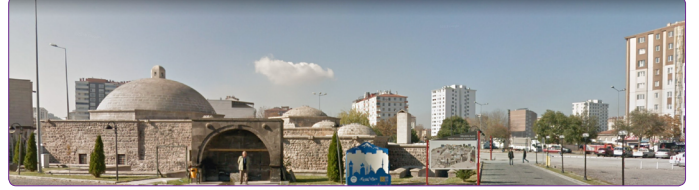
Şekil 23. Kayseri Mahallesi Canlandırma Projesi alanı ve çevresi (Kaynak: Google Earth sokak fotoğrafları).
