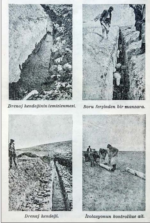
Şekil 7. Boru döşenmesi ve sızdırmazlık kontrolüne ilişkin fotoğraflar.
