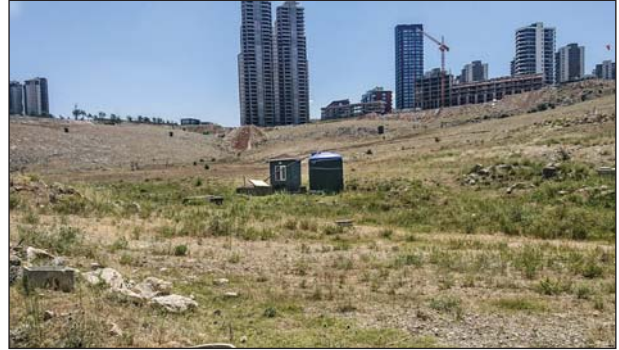
Şekil 23. Kırkgöz kaptaj arazisinde bulunan toplama odası ve hidrofor yapıları. Fotoğraf: Hayrettin Onur Bektaş, 2021.
