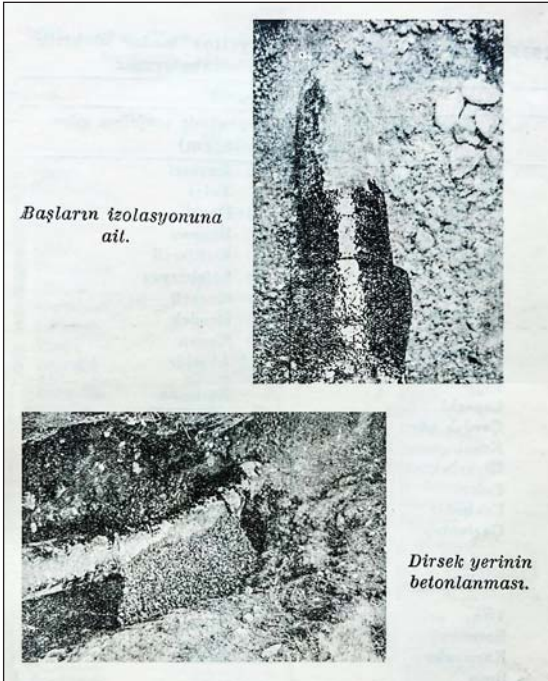
Şekil 11. Boru birleşim ve dirsek imalatları.
