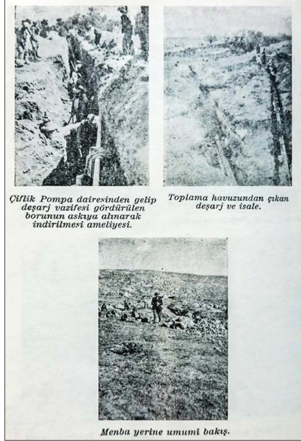
Şekil 8. Boru döşenmesi ve menba yerinin genel görünümüne ait fotoğraflar.
