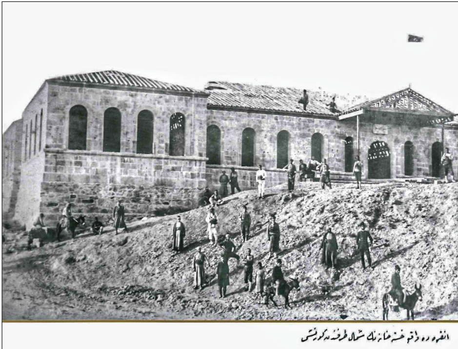
Şekil 23. Gureba Hastanesinin kuzey cephesinden görünüşü. Kaynak: Kavas, 2004, s. 131.
