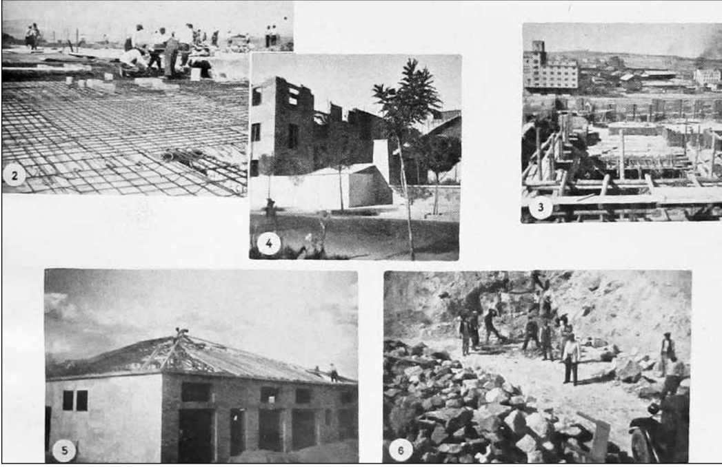
Şekil 21. Radyoevi stüdyo inşaatına ilişkin fotoğraflar. Altlarındaki yazılarda özellikle zeminin kayalık olduğu ve kazı işleminin çok zorlayıcı olduğu vurgulanmış.
