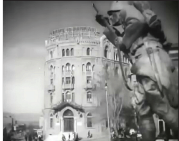
Şekil 3. Meydanı güçlendiren yapı; İş Bankası.
