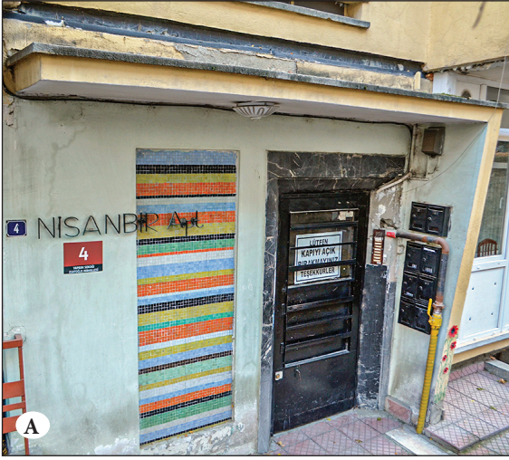
Şekil 15A ve 15B. Nisan Bir Apt. (No.16_K) giriş kapısı yanında tasarlanmış mozaik pano (Z1d) ve Gül Apartmanı (No.28) girişte sağır yüzey, pano etkisi yaratacak biçimde cam mozaik kaplama, düz satırlı kompozisyon (Z1d). Fotoğraf: Araştırma ekibi, Kasım ve Aralık 2024.
