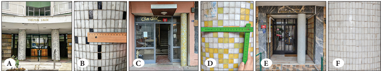
Şekil 14A, 14B, 14C, 14D, 14E ve 14F. Zemin katta giriş ile ilişkilenen cam mozaik kullanımına dair örnekler (Z1c). 14A ve 14B: Yeşiltepe Blokları (No.36); 14C ve 14D: Ongül Apt. (No.13); 14E ve 14F: Yonca Apt. No. 24_K.
