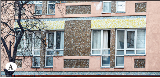
Şekil 22A ve 22B. Ongül Apt. (No.13) ve İsimsiz (No.09) (D3biii) bir apartmandaki cam mozaik uygulamaları. Fotoğraf: Araştırma ekibi, Kasım ve Aralık 2024.
