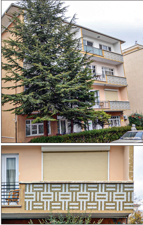
Şekil 17. Gün Apartmanı (No.26) (D1ai) balkon parapetlerindeki cam mozaik görüntüsü. Fotoğraf: Araştırma ekibi, Kasım ve Aralık 2024.
