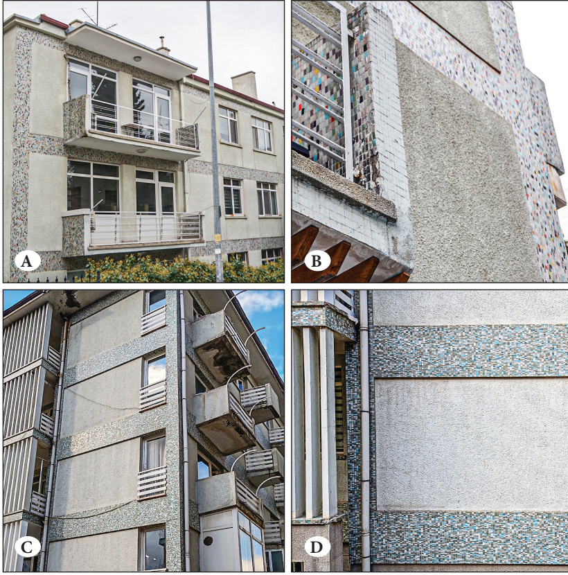
Şekil 24A, 24B, 24C ve 24D. Başak Apt. (No.20) ve Arzu Apt. (No.12) (D5biii) mozaik uygulamaları. Fotoğraf: Araştırma ekibi, Kasım ve Aralık 2024.
