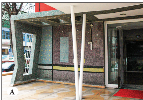
Şekil 4A ve 4B. Ankara'da kamusal alanda Betebe örneği olarak Kızılay Metro İstasyonunda kullanılan ikinci nesil 20x20 (mm) cam mozaikler. Fotoğraf: Araştırma ekibi, Kasım 2024.
