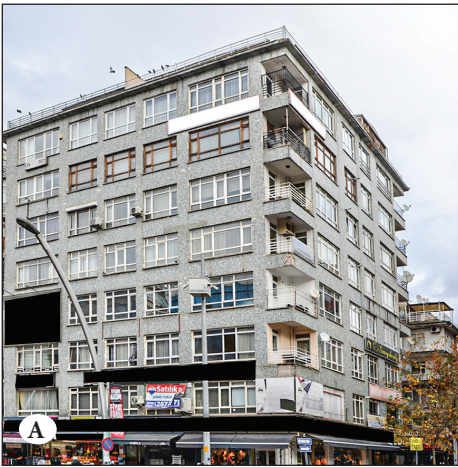
Şekil 22A ve 22B. Ongül Apt. (No.13) ve İsimsiz (No.09) (D3biii) bir apartmandaki cam mozaik uygulamaları. Fotoğraf: Araştırma ekibi, Kasım ve Aralık 2024.
