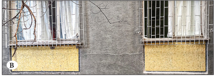
Şekil 22A ve 22B. Ongül Apt. (No.13) ve İsimsiz (No.09) (D3biii) bir apartmandaki cam mozaik uygulamaları. Fotoğraf: Araştırma ekibi, Kasım ve Aralık 2024.
