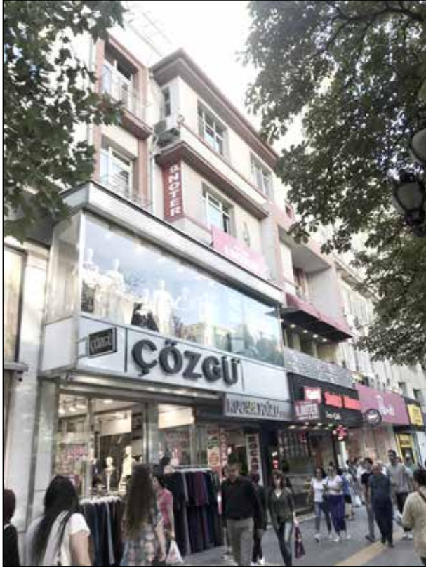
Şekil 15. Toygar Apartmanı'nın Bulvar cephesinden görünümü.
