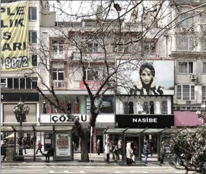
Şekil 12. Toygar Apartmanı'nın Bulvar'dan cephe görünüşü. Fotoğraf: Duygu Hazal Simser, 2020.
