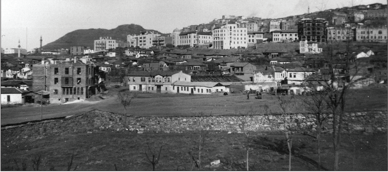
Şekil 5. Ermeni Katolik Mezarlığı içerisinde çekilen duvarın kuzeydoğu birleşimi.
