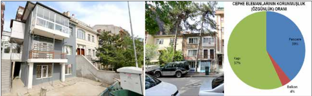
řekil 12. Cephe elemanı deđiřiklikleri ile özgün konut cephesinin farklılařtırıldıđı örnekler ve cephe elemanlarının korunmuřluk durumunu gösteren grafik.
