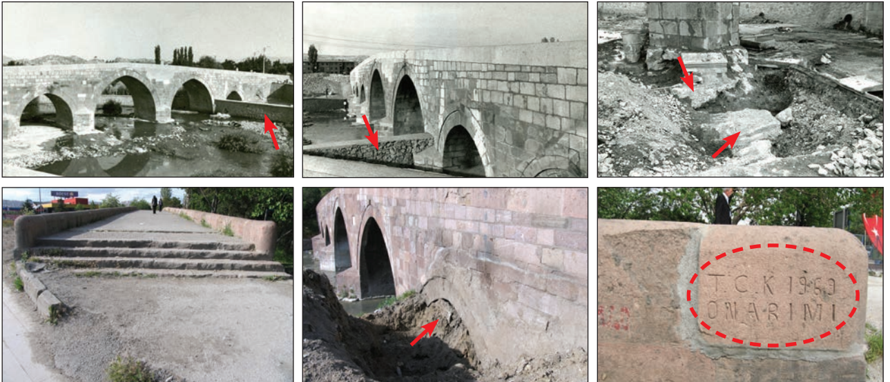
Ek 9. Akköprü'nün 1960 ve 2008 yılı onarımları.
