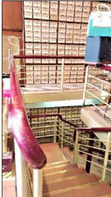
Şekil 16. Plastik malzeme bitişli küpeşte detayı. Kaynak: Güliz Taşdemir Arşivi.
